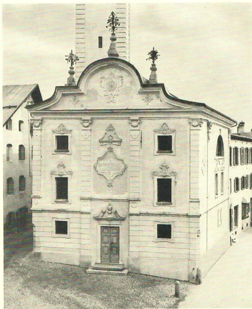
Abb. 380. Samaden. — Die Evangelische Pfarrkirche. Ansicht von Norden vor der Renovation von 1932. — Text S. 379f.
